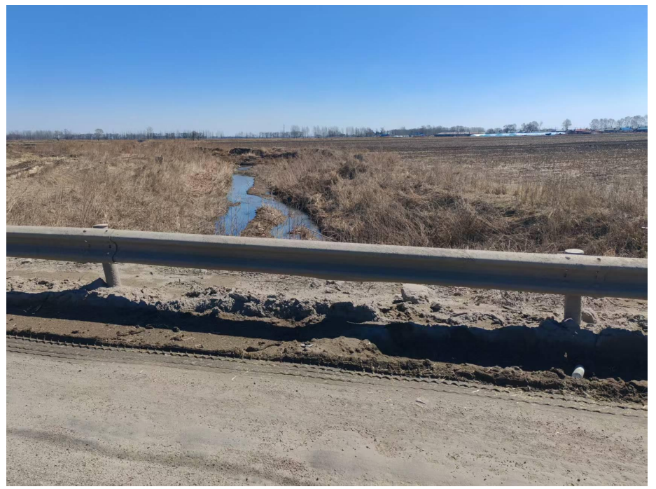
桥梁右侧无名河沟现状照片
