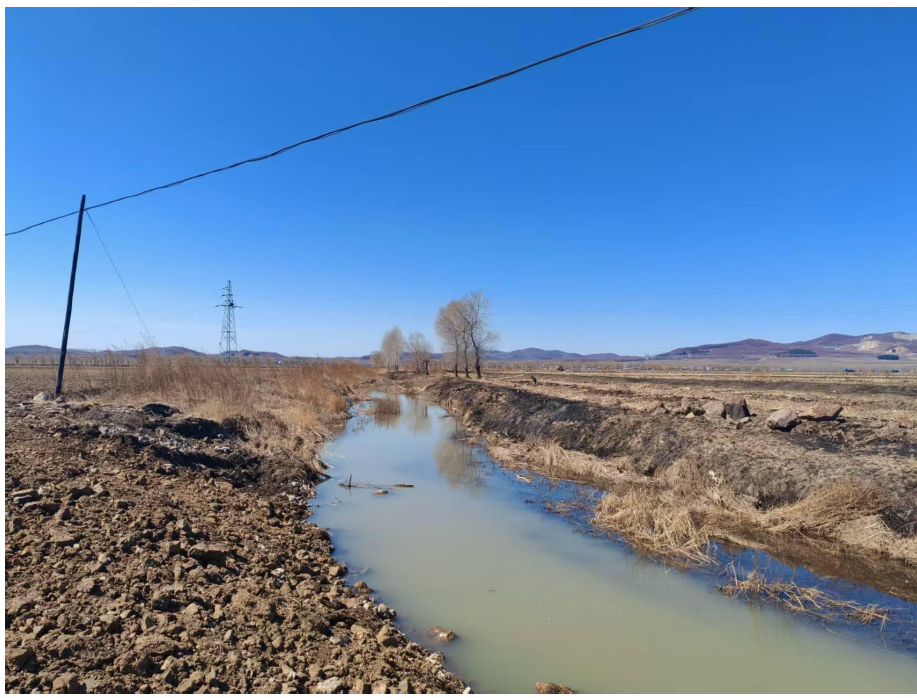
桥梁左侧无名河沟现状照片
