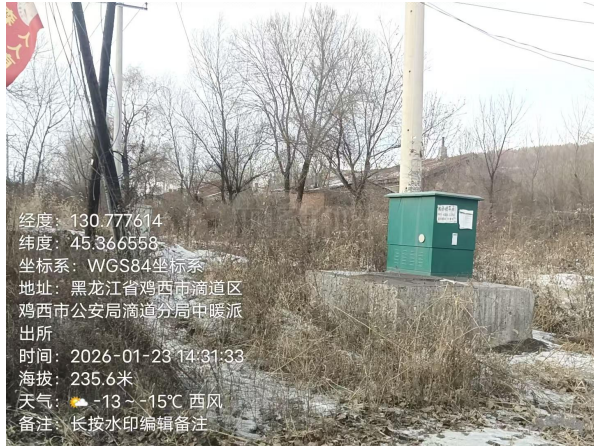
附图6 现场照片（已搬迁的居民空房）
