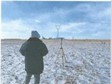
220kV 青珠线 2#-3#塔之间
