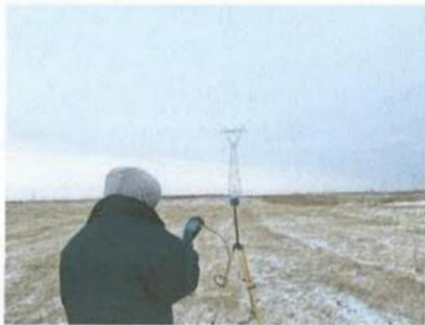
220kV 云珠线 30#-31#塔之间
