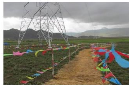
施工时道路边界标识示例
