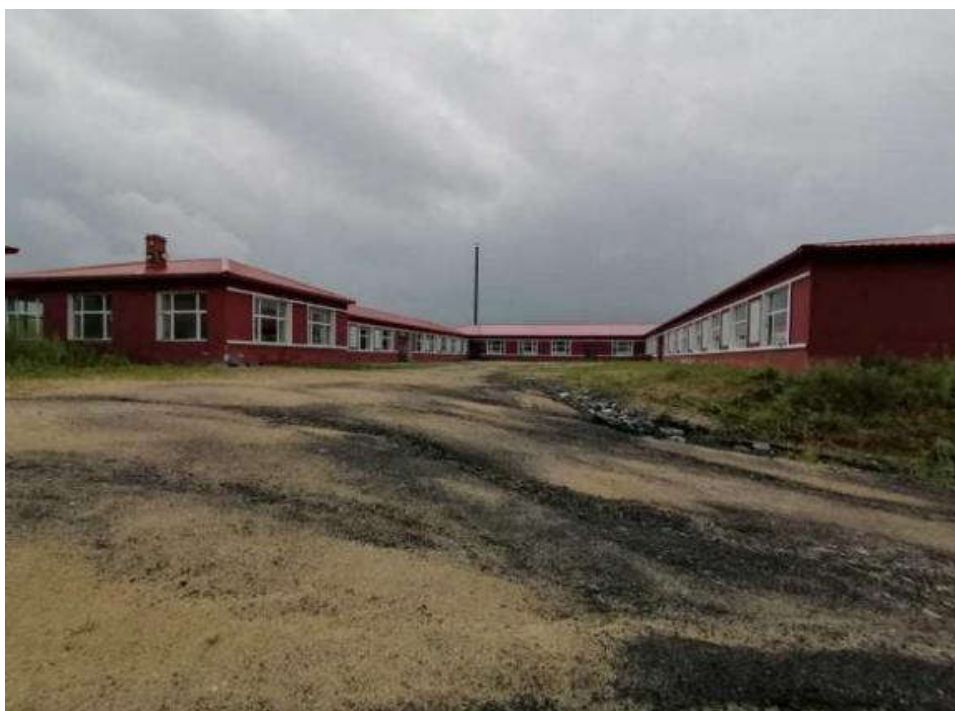
图 3-2 工业广场现状照片
