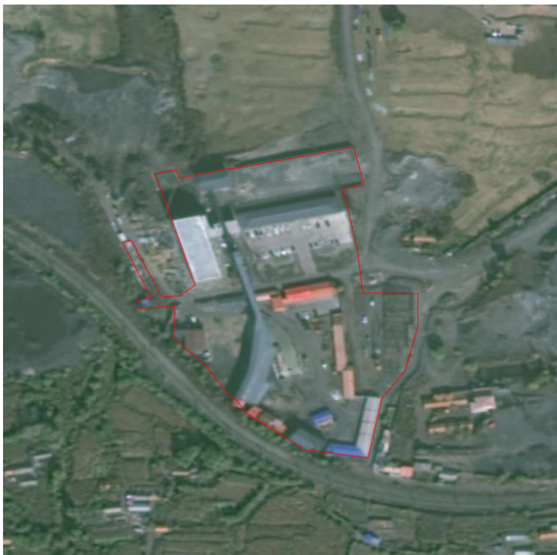
图 1-5 工业广场现状照片
