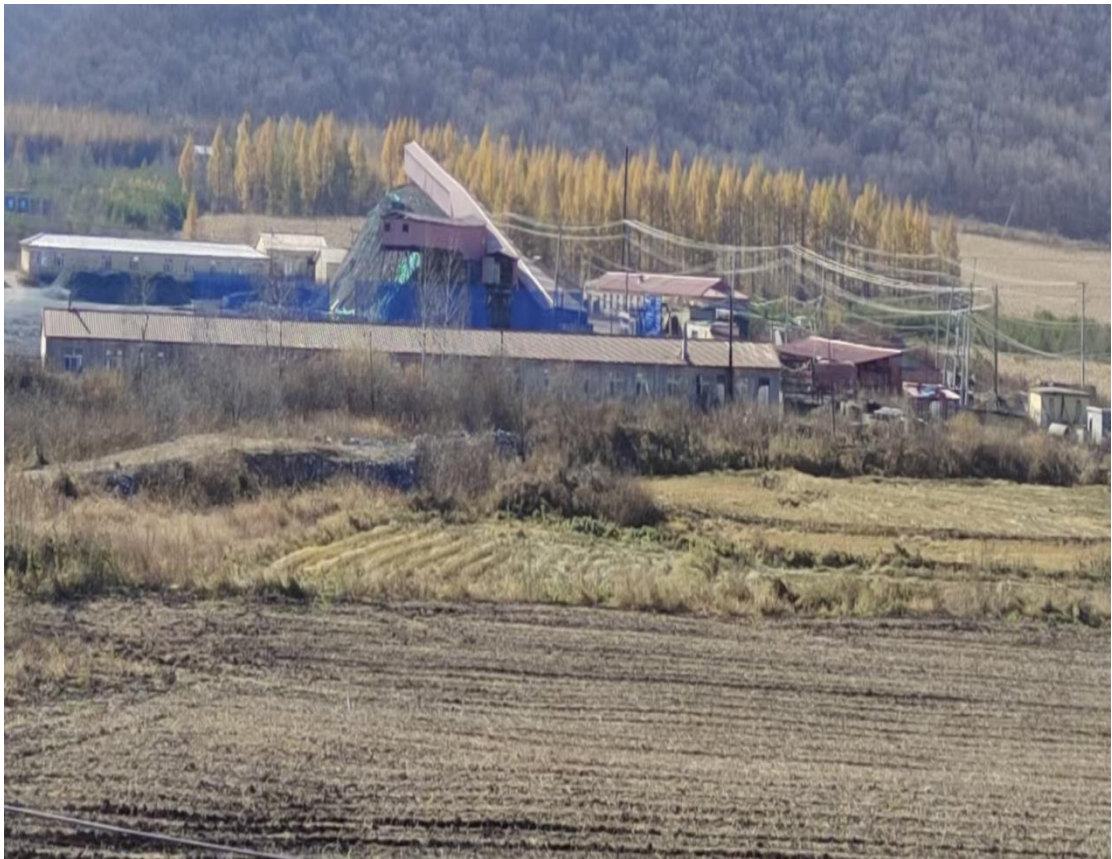
图 3-2 工业广场现状照片
