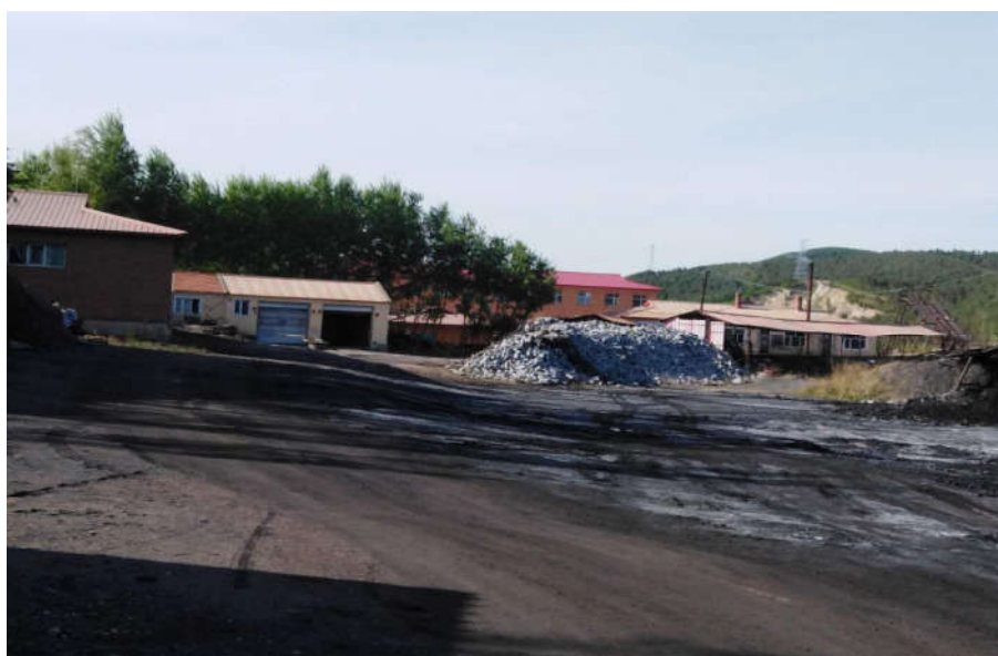
图 3-2 工业广场现状照片
