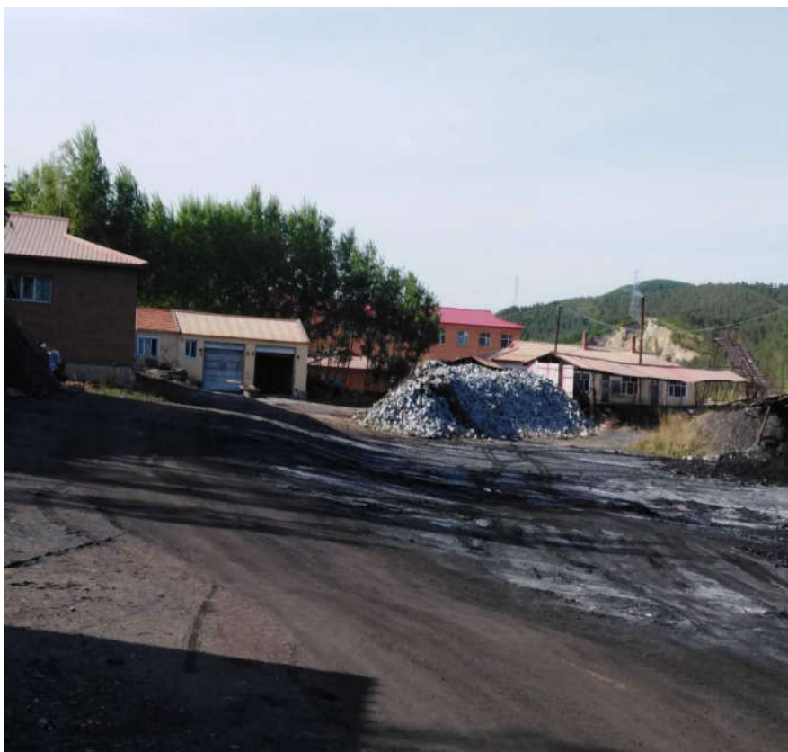
图 1-5 工业广场现状照片
