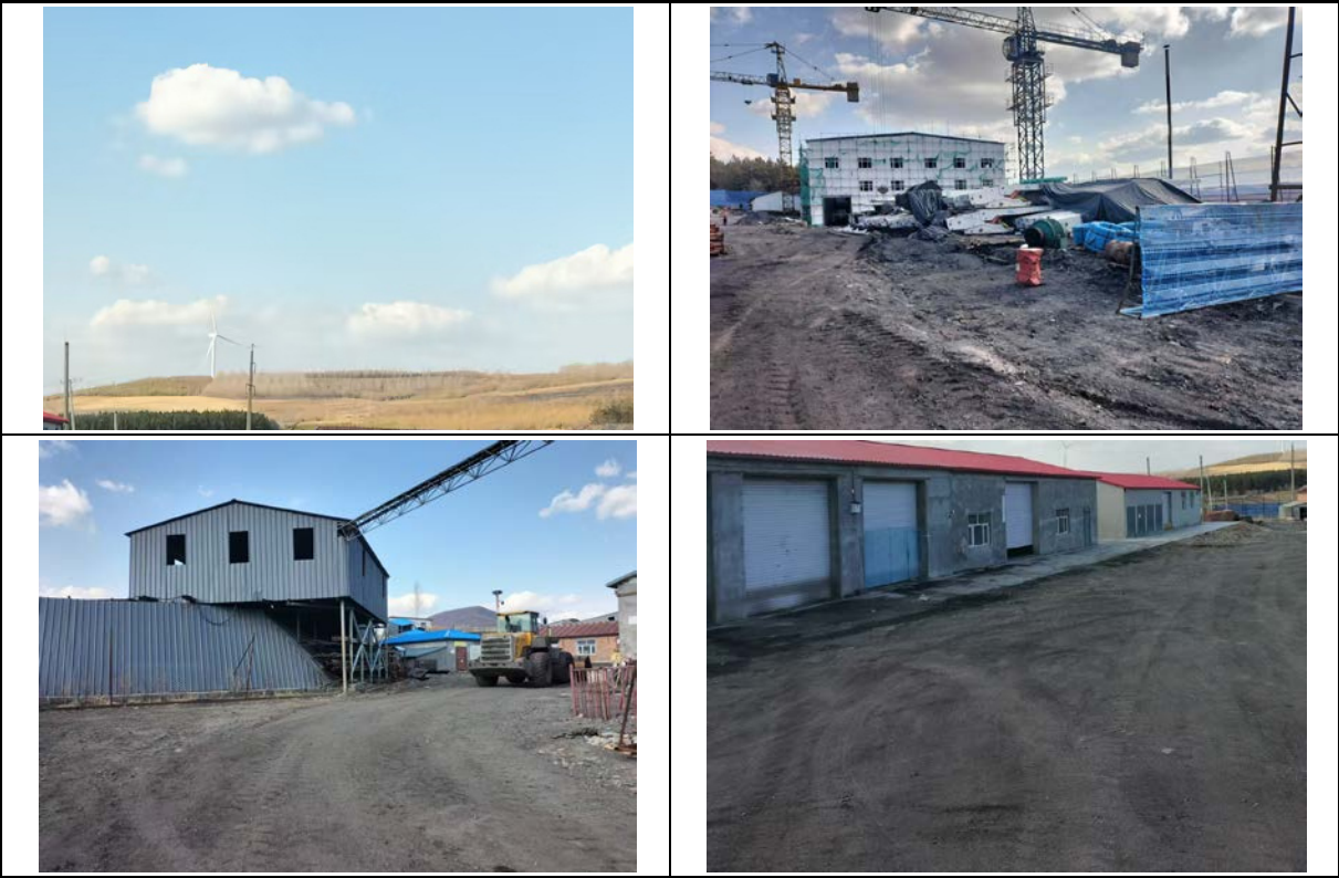
图3-1 现场勘测照片
